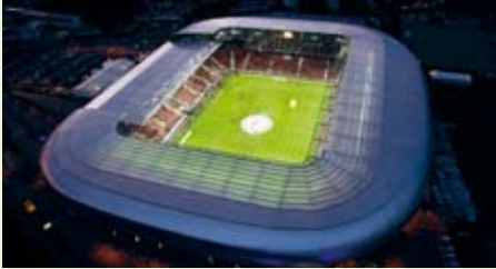
Wörthersee Stadium, Klagenfurt Photo: Stadtpresse Klagenfurt, Horst
